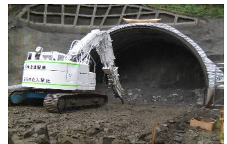
2号トンネル 坑口切羽
