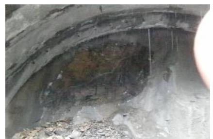
切羽詳細写真
