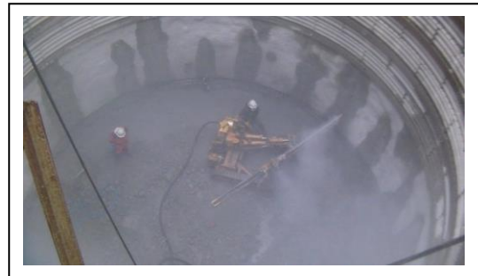
（P 2 ロックボルト用削孔）
