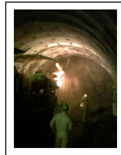
モルタル吹付け作業
